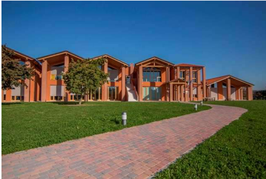
Le strutture edilizie della scuola
