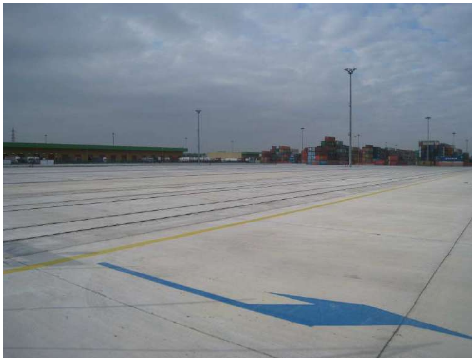
Sistema Terminalistico Integrato - Vista nuovo piazzale
