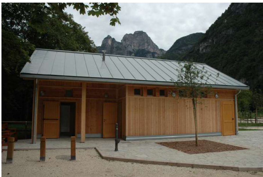
Fabbricato di nuova realizzazione adibito a servizi igienici con docce e bagni per i fruitori dell'area camper
