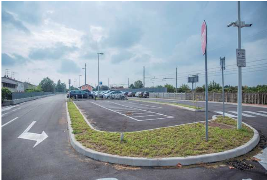
Il nuovo parcheggio per auto adiacente alla stazione di Ceggia
