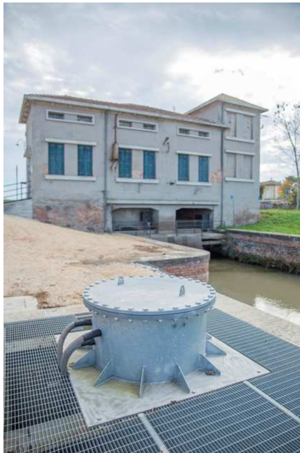
Impianto idrovora e relativa sede
