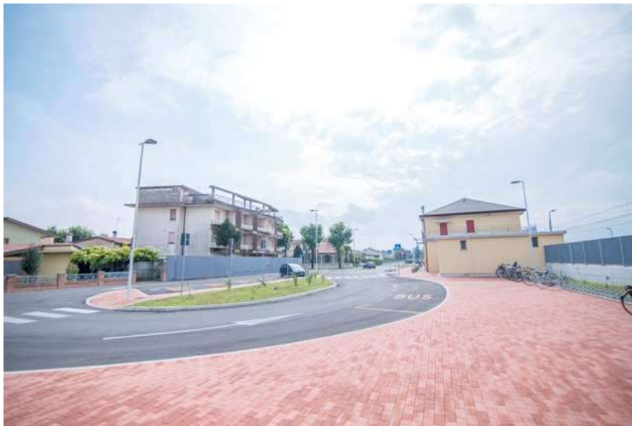
Nuova pavimentazione del parcheggio con rastrelliera per biciclette
