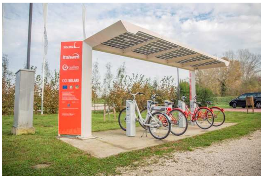
Pensilina fotovoltaica con relative biciclette elettriche
