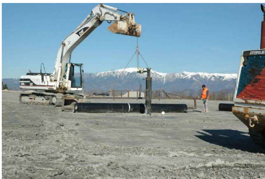
Lavori di bonifica in corso
