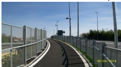
Figura 39 - Lotto 3 – Passerella ciclopedonale
