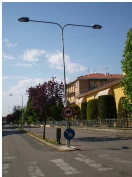
Figura 35 - Adeguamento impianti di pubblica illuminazione del Comune di Poggio Rusco
