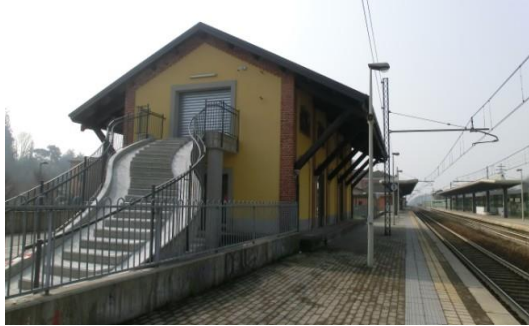
Figura 43 - Ingresso piano 1° cicli - lato nord: vista da banchina ferroviaria binario 1
